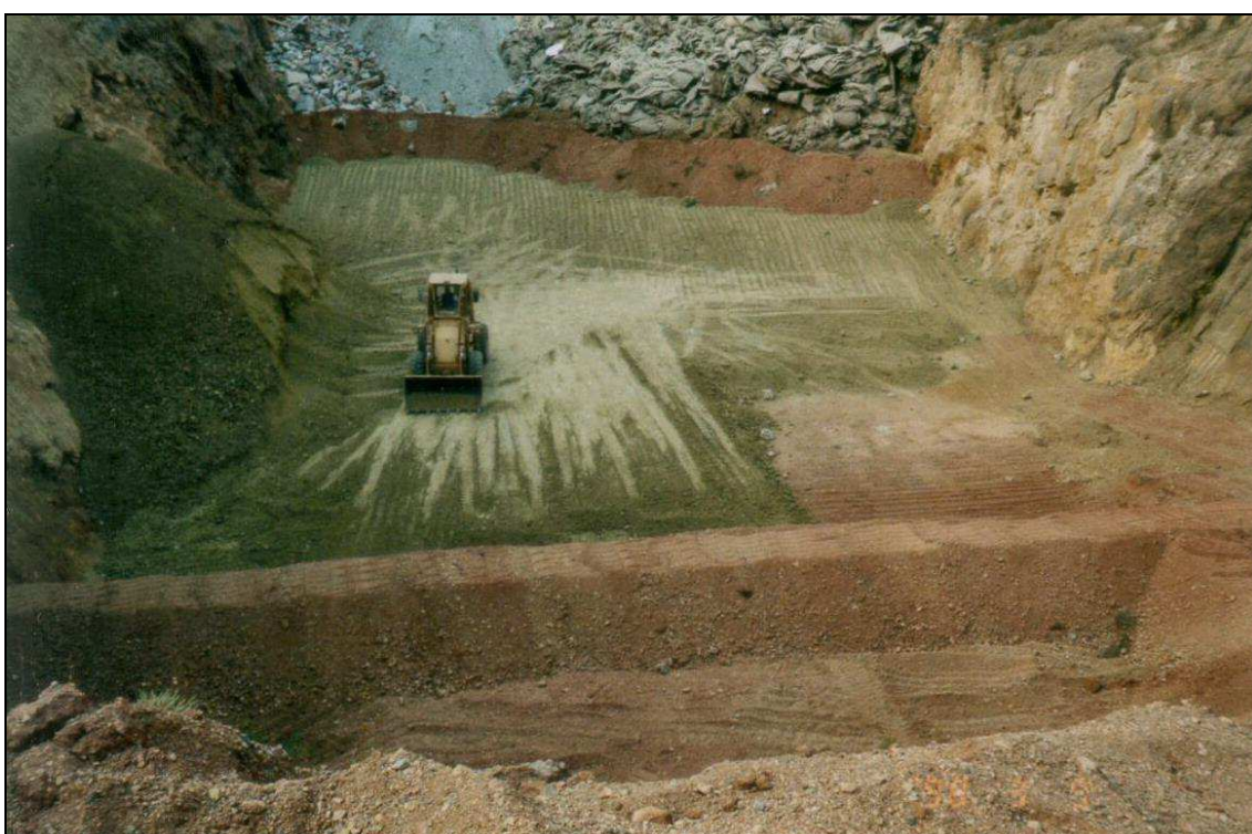
Foto 9 – Lavori di impermeabilizzazione del fondo della discarica – Vista da Sud/Ovest
